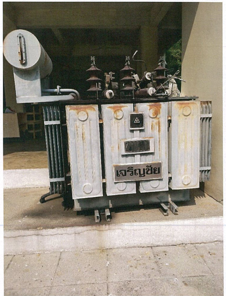
พัสดุชำรุดเสื่อมสภาพ รายการหม้อแปลงไฟฟ้าขนาด 750 KVA และ ตู้ MDB
